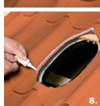
8. Смазать силиконом очерченный участок между краем отверстия и линией внешнего контура.
