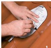
1. Очертить отверстие по шаблону. Отмеченную на шаблоне точку совместить с нижней точкой волны черепицы , в зависимости от длины профиля металличерепицы.
