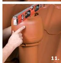
11. Установить VILPE изделие на проходной элемент, проверив вертикальность уровнем, и закрепить шурупами.
