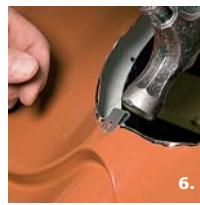
6. Насадить молотком клипсы на металличерепицу в верхней и нижней точке крепежа проходного элемента так, чтобы при крепеже шурупы прошли сквозь клипсы.
