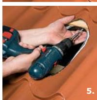
5. При **битумной** гидроизоляции нижнюю поверхность уплотнителя промазать резинобитумной мастикой. Прижать уплотнитель к гидроизоляции и закрепить шурупами к деревянной основе. При **пленочной** гидроизоляции промазать силиконом внешнюю поверхность уплотнителя (с шипами). Прижав уплотнитель к пленке снизу, наколоть пленку на штифты и уплотнить соединение силиконом. Закрепить уплотнитель шурупами к верхней и нижней рейке обрешетки.
