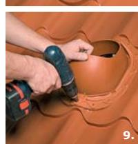
9. Установить проходной элемент и закрепить сначала верхний и нижний край шурупами через клипсы.
