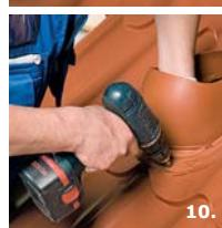
10. При сильном отклонении профиля металла от базового профиля проходного элемента возможно прокручивание боковых шурупов. В этом случае следует присверлить боковые шурупы в местах наибольшего отклонения профиля через дополнительные клипсы, что обеспечит плотное прижатие проходного элемента к металлу, затем присверлить остальные шурупы.
