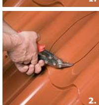
2. Вырезать отверстие в металличерепице электролобзиком строго по очерченному контуру.
