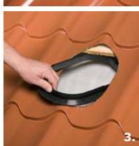
3. Вставить уплотнитель гидрозатвора в вырезанное отверстие, совместить отверстие уплотнителя с отверстием металличерепицы.
