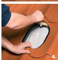
4. Обрисовать контур отверстия уплотнителя и вырезать отверстие в гидроизоляционной пленке строго по контуру.
